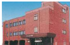
シティホール掛尾 富山市黒瀬北町2-4-4 ☎076-423-4444
