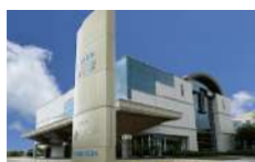
シティホール 玉泉院 金沢市松島1-29 ☎076-269-1234
