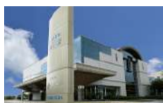
シティホール玉泉院 金沢市松島1-29 ☎076-269-1234
